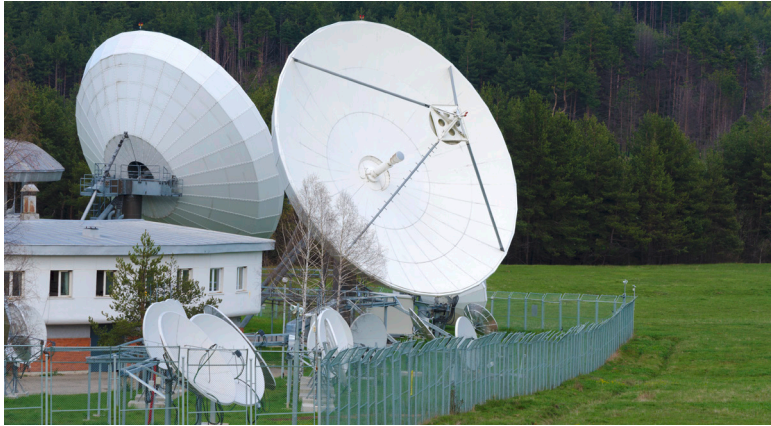
Fig. 62: Teleport antenna site
